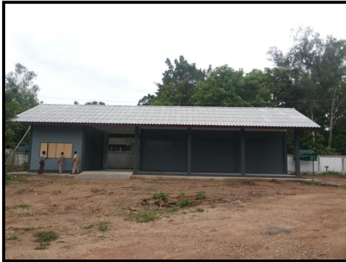
ก่อสร้างอาคารอเนกประสงค์ (ภายในสำนักงานฯ)
