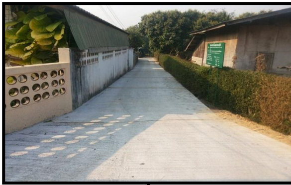
ก่อสร้างถนนคอนกรีตเสริมเหล็กหมู่ที่ ๗ (ซอยบ้านนายเขว)
