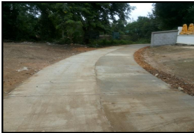
ก่อสร้างถนนคอนกรีตเสริมเหล็กหมู่ที่ ๑๐ (เชื่อม ๒ หมู่บ้าน)
