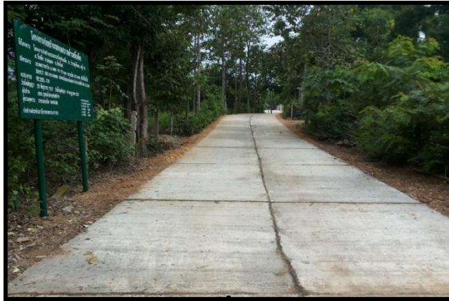
ก่อสร้างถนนคอนกรีตเสริมเหล็กหมู่ที่ ๑๐ (หมู่บ้านพี่น้องชนเผ่า)
