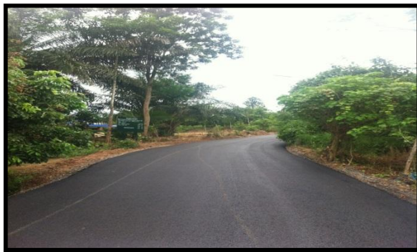
ก่อสร้างถนนแอสฟัลท์ติก หมู่ ๘ (ซอย ๑)
