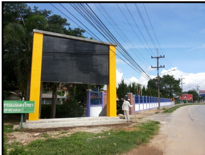
โครงการก่อสร้างป้าย สำนักงานและรั้วสำนักงานฯ
