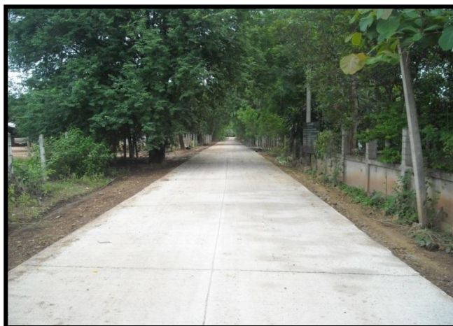
ก่อสร้างถนนคอนกรีตเสริมเหล็กหมู่ที่ ๑๑ (ฟาร์มหมู)
