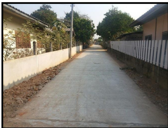
ก่อสร้างถนนคอนกรีตเสริมเหล็กหมู่ที่ ๗ (ซอย ๑๗)
