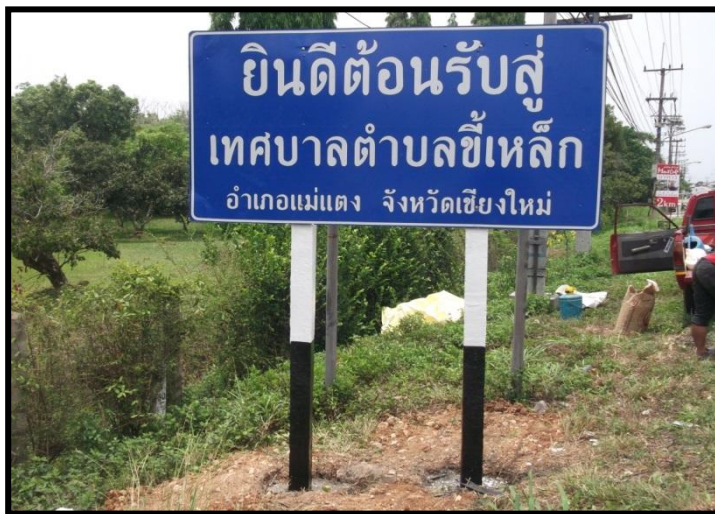
ก่อสร้างป้ายแนะนำ/บอกทาง (ก่อนถึง ทต.ชี้เหล็ก) สำหรับผู้ สัญจรทั่วไป/ผู้มาติดต่อ
