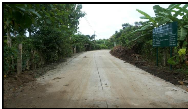
ก่อสร้างถนนคอนกรีตเสริมเหล็กหมู่ที่ ๙ (หมู่บ้านพี่น้องชนเผ่า)
