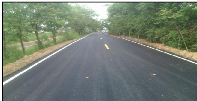
ถนนแอสฟัลต์ติกคอนกรีต บ้านทรายมูล หมู่ที่ ๕ – บ้าน ขี้เหล็ก อ.แม่ริม (งบอุดหนุนฯ)
